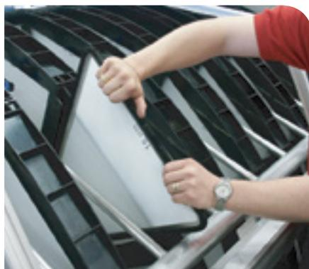
Чтобы снять фильтрующую панель, требуется отсоединить всего два крепления. Инструменты не нужны.
